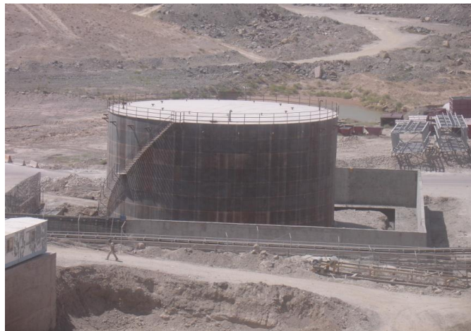
شکل ۱- مخزن ۱۰ هزار متر مکعبی مازوت شرکت سیمان مشهد
