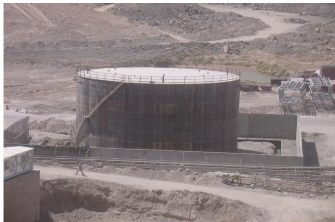
شکل ۱- مخزن ۱۰ هزار متر مکعبی مازوت شرکت سیمان مشهد
