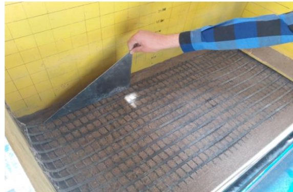
الف: اجرای قسمت افقی پایین ژئوگرید
